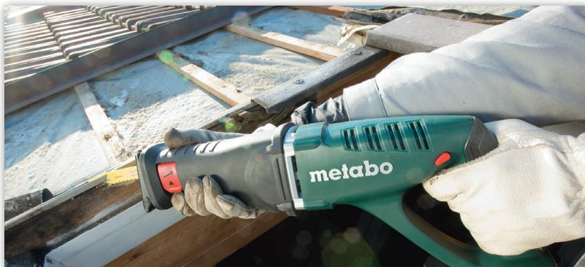
\* Die BG Bau fördert die Verwendung von Säbelsägen, um Gefährdungen durch den Einsatz von Ketten-
